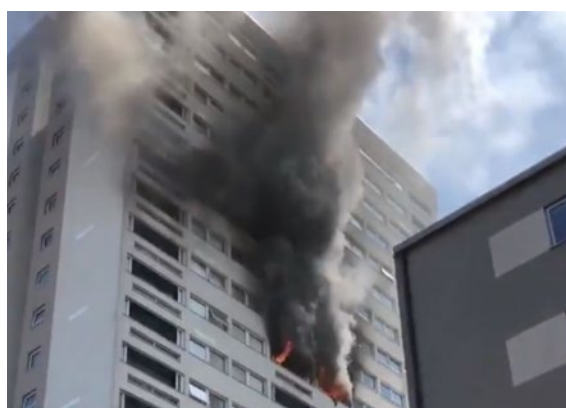
Foto 1: De rook verspreidt zich in eerste instantie langs de gevel.
